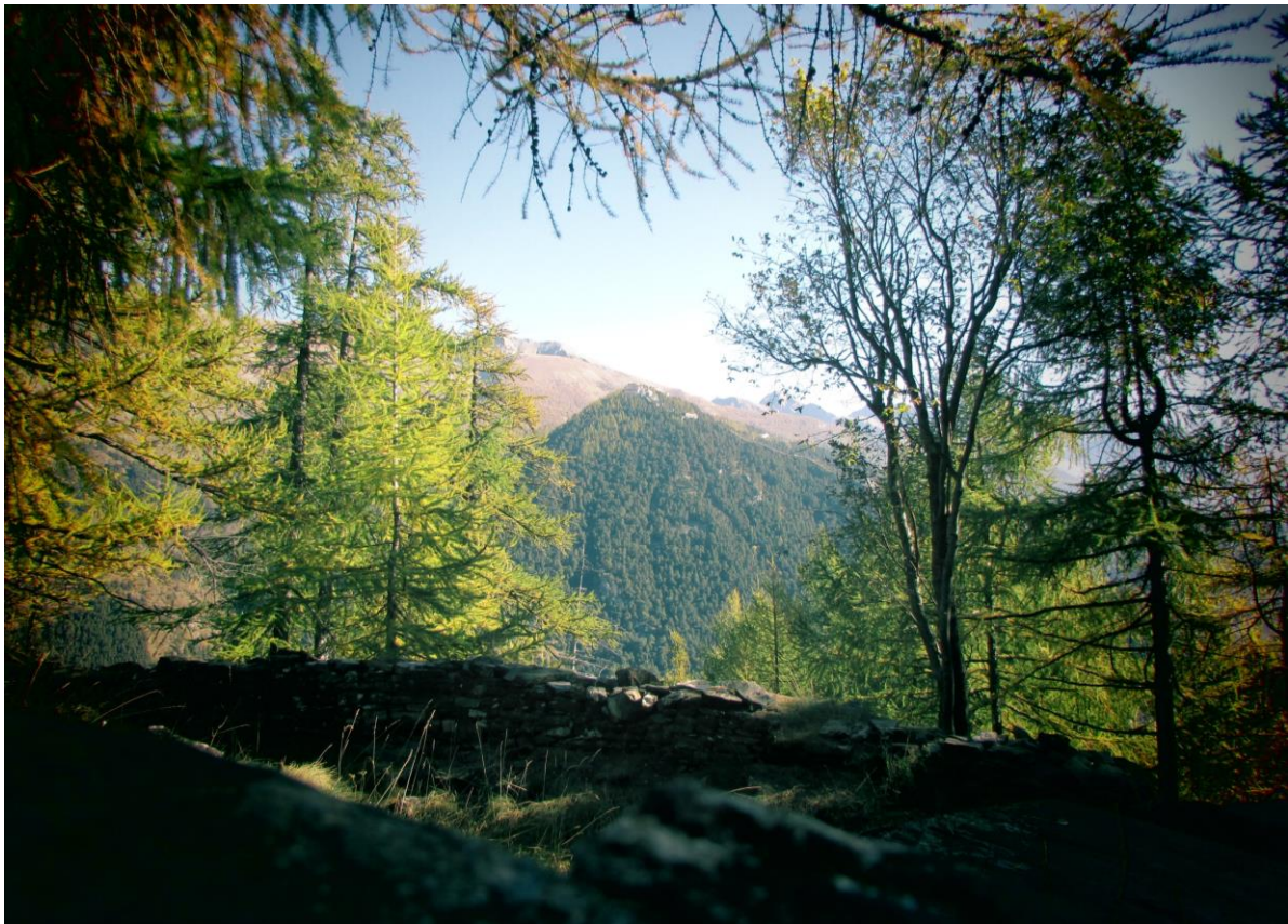
La parte alta del forte di Fenestrelle, vista dalle ridotte del Fort Mutin – Foto di Simona Pons
